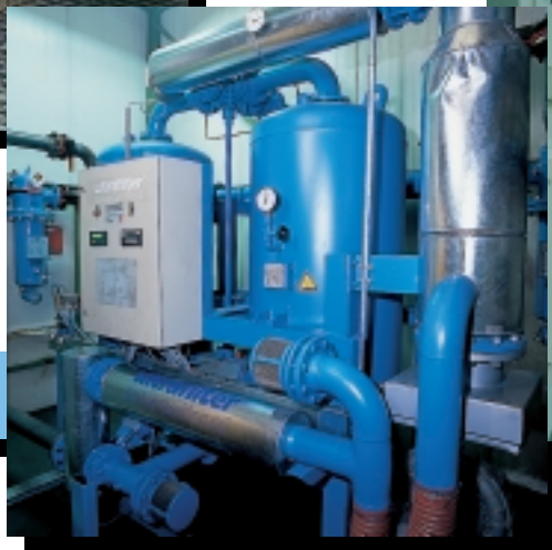
Die neue Drucklufttrocknung auf Adsorptionsbasis
